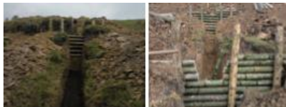
Imagen 2. Ejemplo 2 de intercepción de aguas por canales
